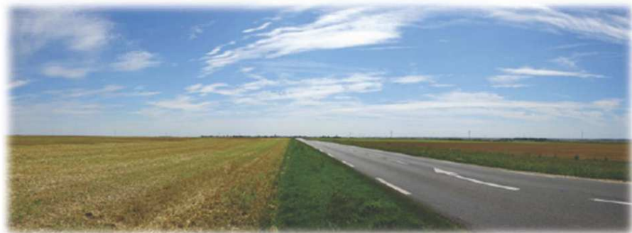
Figure 150 : Depuis la RD 950, les vues en direction de la ZIP sont ouvertes sur le milieu agricole (Source : Étude paysagère de l'Agence Couasnon)
