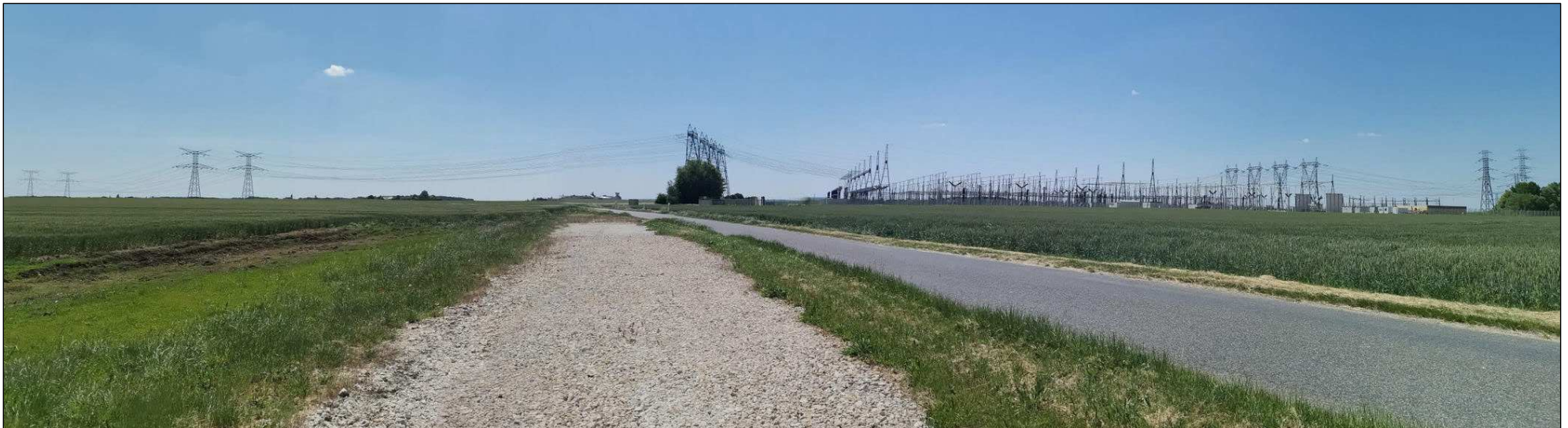
Vue 8 : Vue panoramique depuis l'ouest de l'aire d'étude immédiate, à proximité du poste électrique, en limite de la zone d'implantation potentielle, en direction du sud-ouest.
