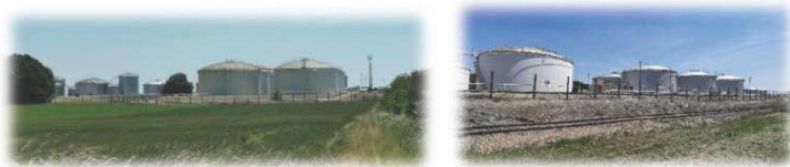
Figure 58 : Photographies de la société VARO ENERGY FRANCE DEPOT (Source : NCA Environnement)
