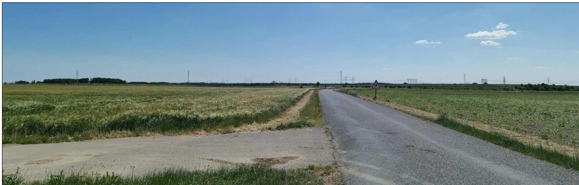
Vue 20 : Vue panoramique depuis le nord de l'aire d'étude immédiate et de l'A19, entre « les Favières » et « la Croix Saint-Jacques », en direction du sud, vers la zone d'implantation potentielle.
