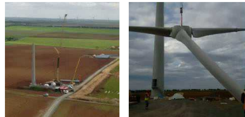
Figure 30 : Montage du mât (à droite) et levage du rotor (à gauche) (Source : ENERCON)
