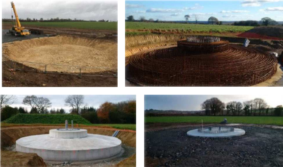
Figure 29 : Mise en œuvre d'une fondation (Source : ENERCON)
